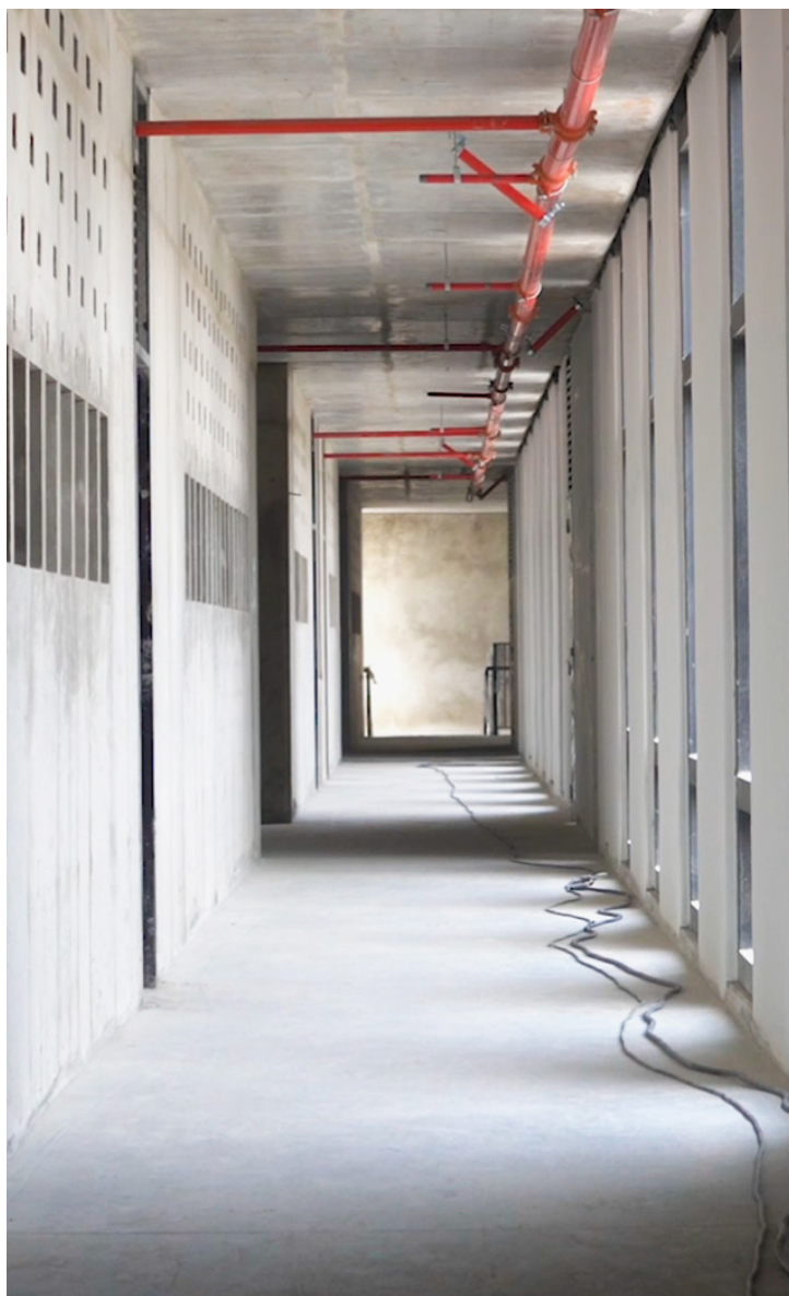
Con paso firme avanza la construcción del Centro Integral de Justicia de Campo Verde, que agrupará diversos equipamientos que prestarán servicios de justicia formal, no formal y comunitaria, y en donde los ciudadanos podrán resolver de manera pacífica sus conflictos.
