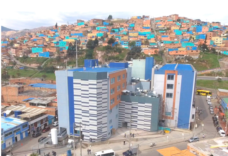
La vigilancia a las obras de ampliación de los hospitales del Distrito ha sido una prioridad para la Contraloría de Bogotá. En la foto, panorámica del Hospital de Meissen.
