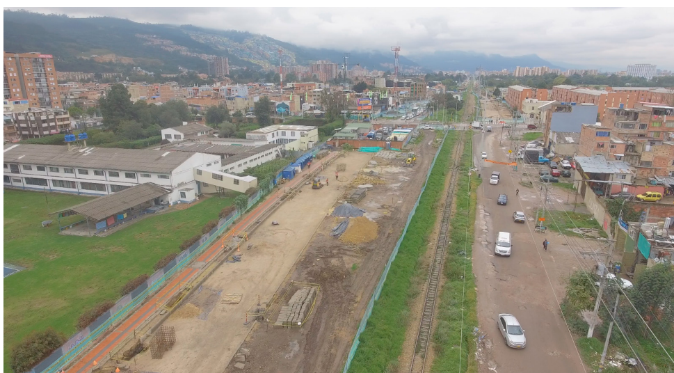
Esta es la ampliación de la Avenida Carrera Novena, entre las calles 170 y 193, obra que tiene cerca de 4 años de retraso. Hoy, la construcción tiene un avance físico del 23,54 por ciento. Gran parte del retraso del proyecto se debe la demora en el cambio de la etapa de diseño a etapa de construcción dentro del contrato (se tomó más tiempo del establecido).
